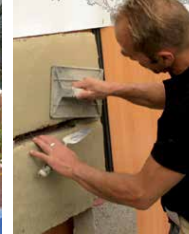
CONSTRUCTION & ECO BÂTIR
