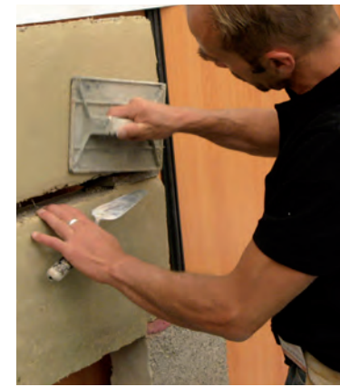
CONSTRUCTION & ECO BÂTIR
